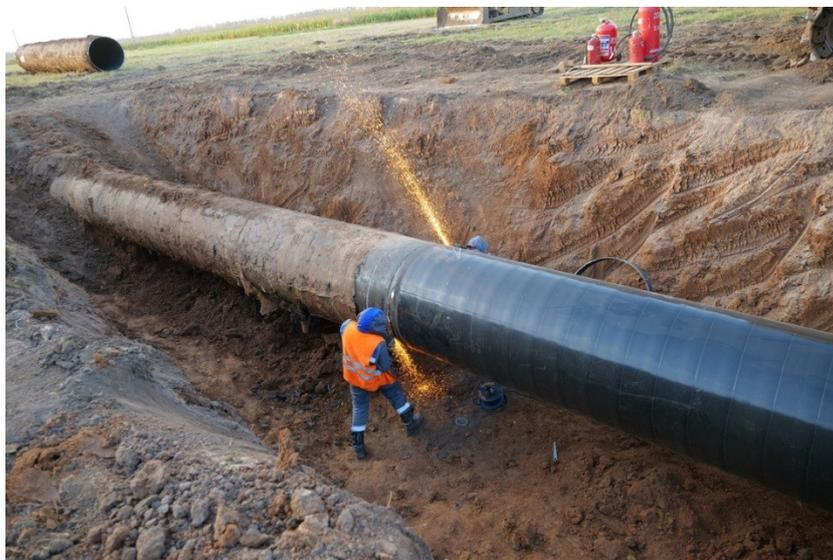
Рис. 2.1. Полная замена трубы для устранения дефектов, обнаруженных в результате ВТД.
